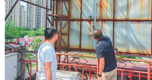
6月13日，文化传媒开展安全隐患大排查。检查人员对客运东站楼顶、停车场及其周边的户外广告牌进行检查，确保广告牌的铁架焊接部位安全完好和画面完整，排除大风天气可能带来的安全隐患。并对大修厂园区停车场及所有通道进行检查，确保畅通无阻。此外，在园区群内提醒租户注意电瓶车的停放和充电安全，要求租户在室外充电桩集中、有序地停放和充电。
