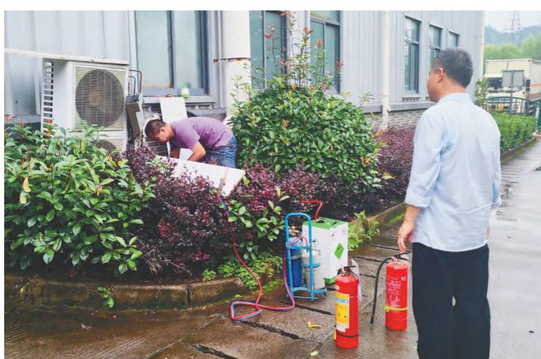
师傅详细检查后发现，空调的外机制冷液管道出现了破损，需要立即进行焊接修复。
